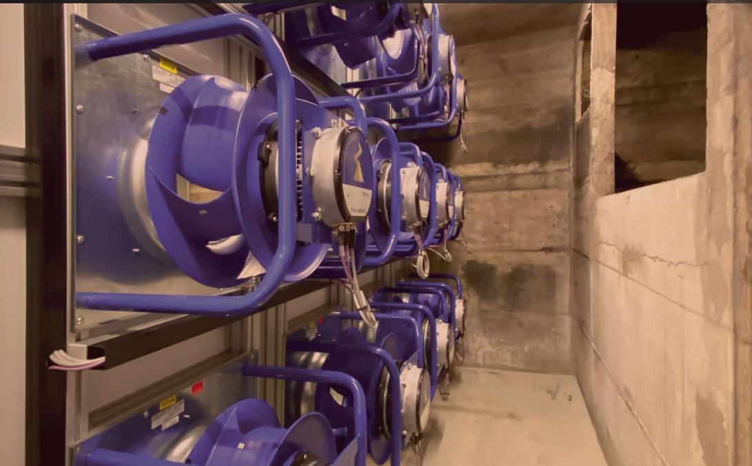
In diesem Beispiel wurden zwölf Ventilatoren in einer Wand verbaut. Das System ist hochredundant, da bei einem Ausfall eines einzelnen Lüfters die übrigen nachgeregelt werden.
